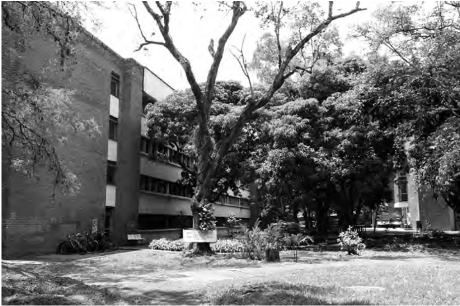
Sede DIE-UNIVALLE Edificio 388-Ciudad Universitaria Meléndez
